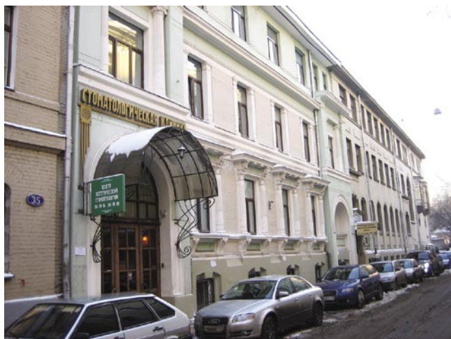
Здание бывшей хирургической лечебницы князя А.В. Чегодаева, где в последующем был надстроен III этаж (2007)
