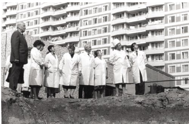
Главный врач Центральной больницы А.А. Тимофеева (вторая справа) у котлована, где начиналась закладка фундамента будущей поликлиники (1984)
