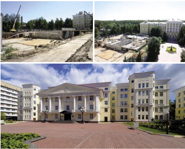
Рис. 2. Этапы строительства здания клиники грудной и сердечно-сосудистой хирургии им. святого Георгия (19 корпус) (вверху) (фото июнь 2005), современный вид здания клиники (фото июнь, 2011).
